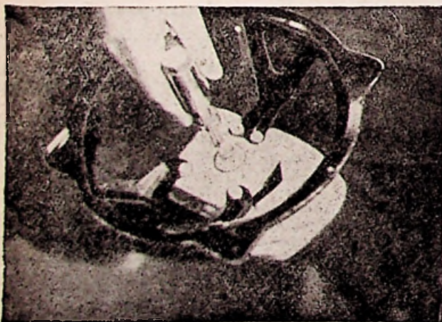
Fig. 16. — Voor het inzetten van den conus wordt de luchtspleet van de magneet met perslucht uitgeblazen en van stof en splinters gezuiverd.
